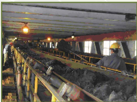
煤矿皮带输送线
